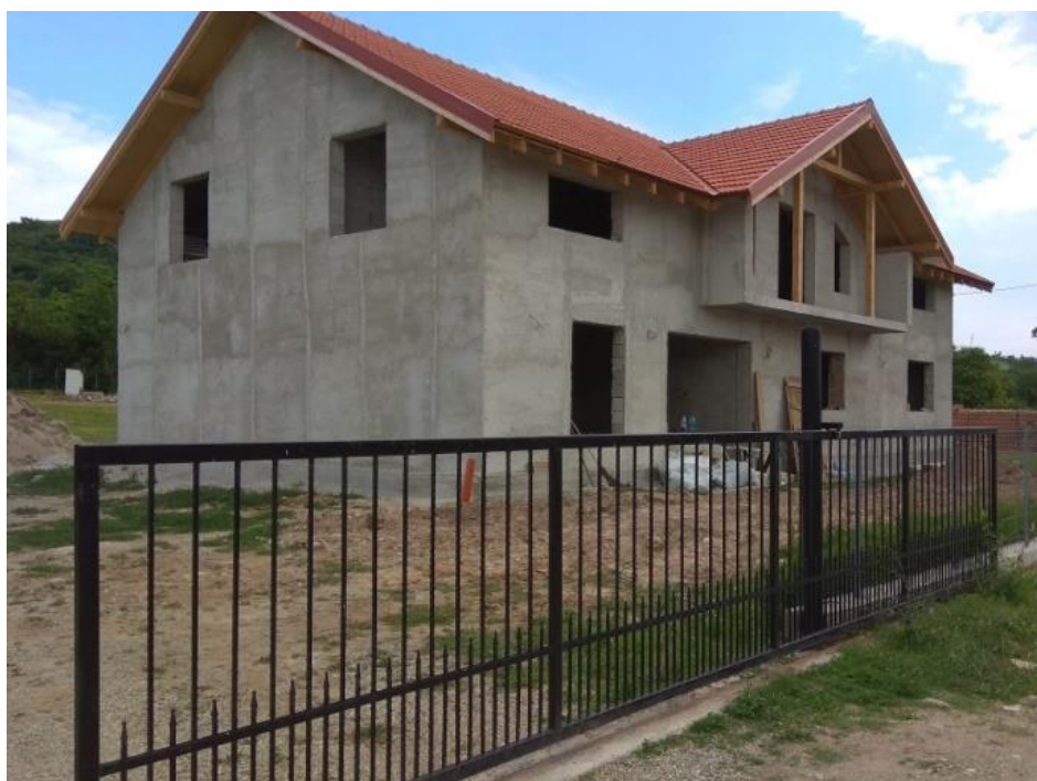
Figura 7.2. Casă în construcție, comuna General Berthelot (foto: Adrian Băneș)
